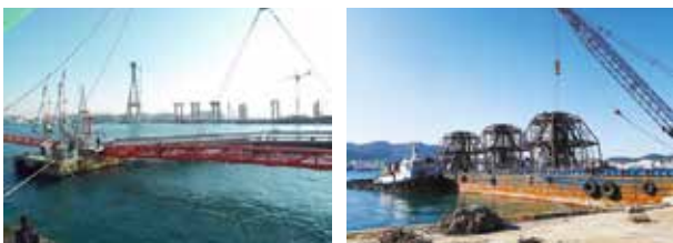
해상 구조물 시설 공사
