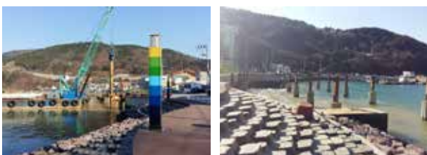
해상파일 설치 공사
