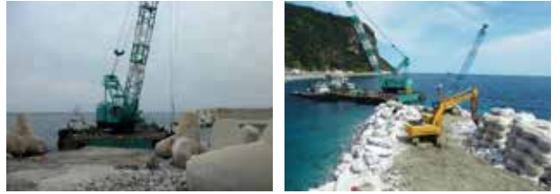
블록 설치 및 방파제 공사
