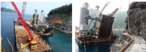
해안 탐방로 조성 공사
