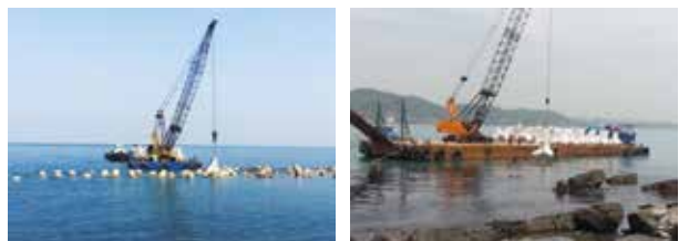
잠제 설치 공사
