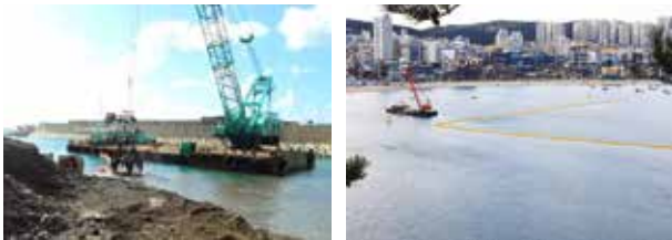
항만 부지 조성 공사
